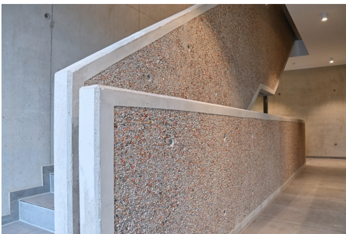
Treppenbrüstung in Recycling-Beton mit Typ 2 Material mit bearbeiteter Oberfläche
